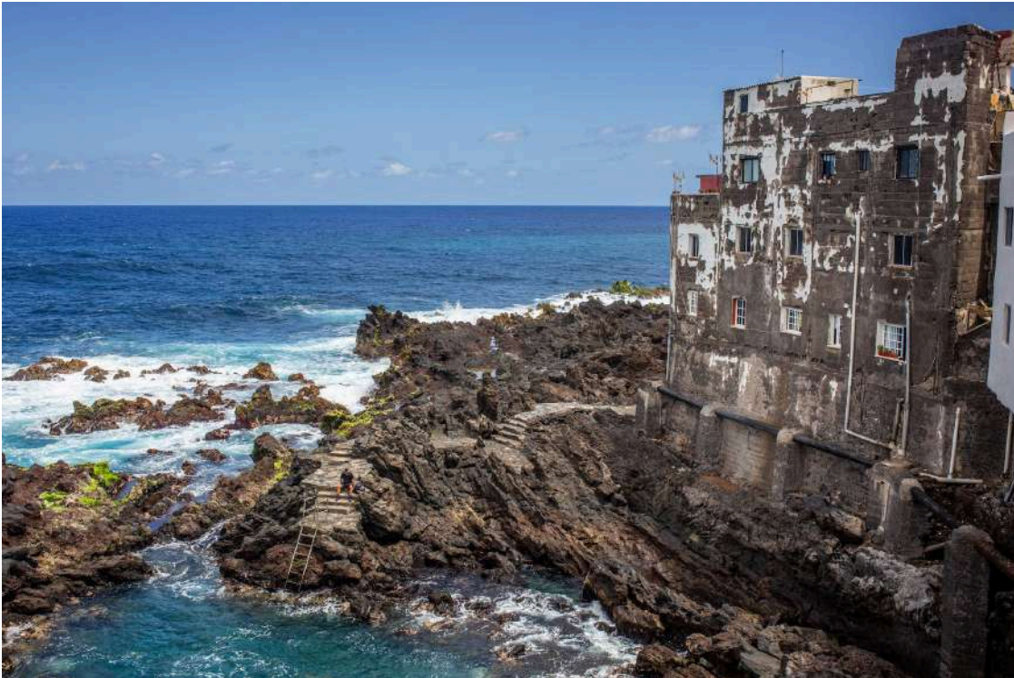
En esta zona de Punta Brava se encuentra el emisario submarino, cuya avería provocó la contaminación y el cierre de Playa Jardín. Paula González Gavilanes
